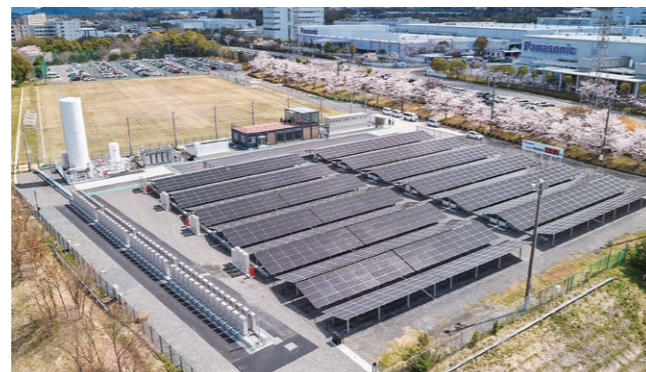
パナソニック(株)草津工場(純水素型燃料電池と太陽光パネルによる電力供給)
