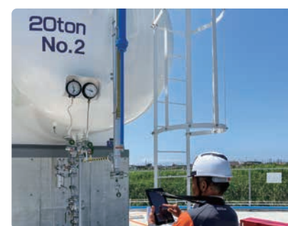
タブレットを活用した工場設備点検
